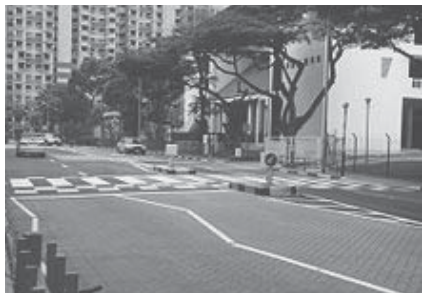
Рис. 2. Пример совмещения пешеходного перехода и ИН в школьной зоне в Сингапуре
